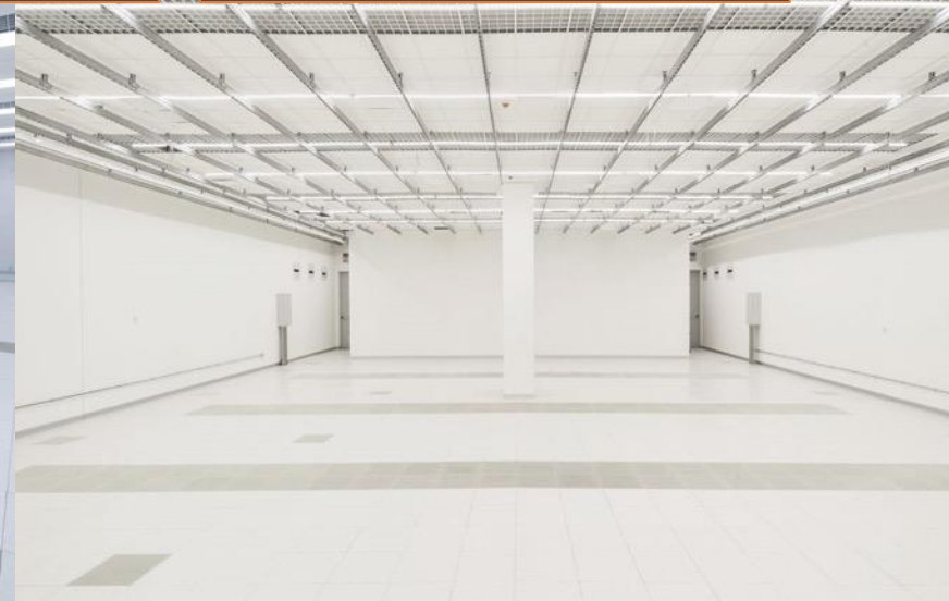
Data Center Dedicato
